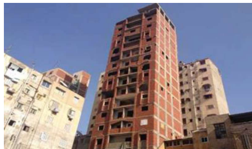
شكل(3) صورة توضح مخالفات المباني وتؤكد اختراق القوانين
