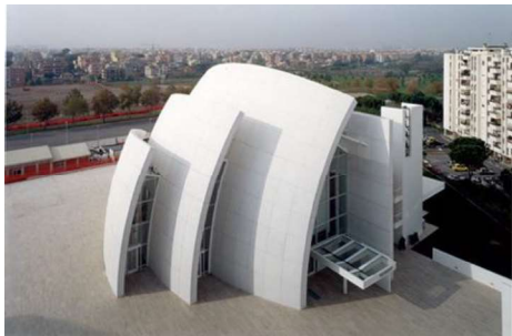
شكل(٤) كنيسة البوبيل في روما توضح الجدران المنحنية من الخرسانة النشطة المصدر (Leydecker, S. 2008)
