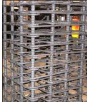
ازدحام في العمود في الحديد العادي ازدحام في الحديد النانوي شكل (٦) مقارنة بين كمية الحديد التقليدي والحديد MMFX2 النانوي المصدر: http://www.mmfx.com/advantages/service-life/
