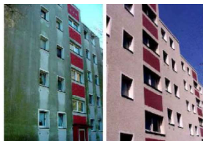
شكل ٥ الفرق بين الواجهة المغطاه بطبقة ضد الميكروبات و أخرى المصدر: وليد محمد بلال حسين، ٢٠١٦
