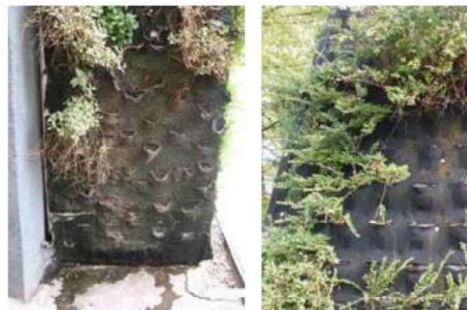
شكل 15. يوضح أجزاء عازية لنظام طبقة البلاء felt مع نباتات مينة ، وجيوب ممزقة وتدهور لوحها. [2]
