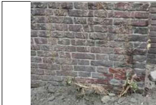
شكل 14. يوضح بقاء هيكل الجذر اللاصق بعد إزالة النباتات من الجدار. [14]
