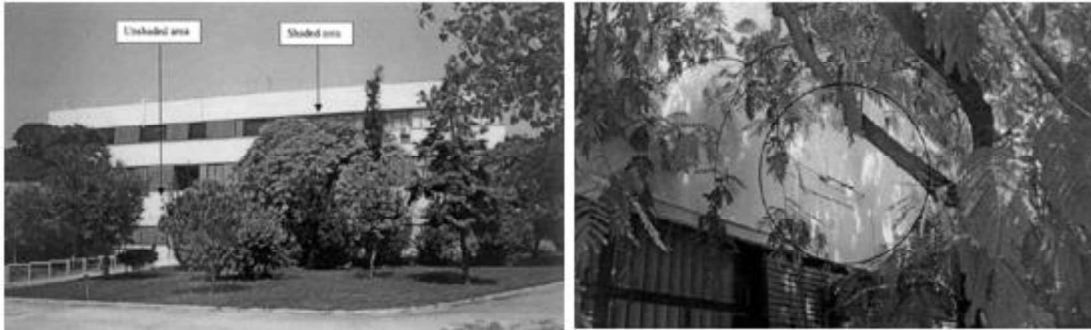
شكل7. يوضح موقع ادوات قياس الاشعاع الشمسي في المنطقة المظلة والغير مظلة بالواجهة. [2]
