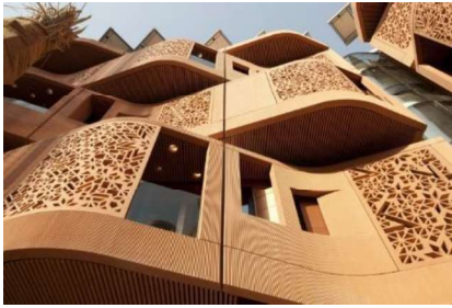
شكل (١٢) شكل المشربية الخرسانية
