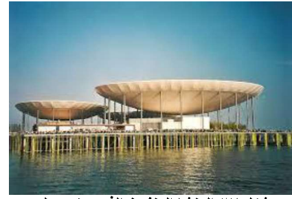
شكل ٢٧ المنشأ المنفوخ الذي يعتمد على تكنولوجيا ضخ الهواء لجعله أخف ويسهل حمله على الاعمدة الصغيرة
