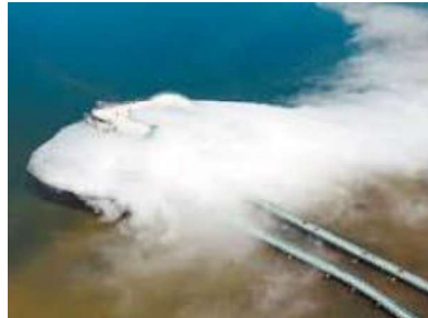
شكل ٢٨ مبني السحاب الصناعي الذي يتكون من انابيب دقيقة جدا لخراج مياه بشكل قطرات صغيرة جدا تعمل شكل السحاب
