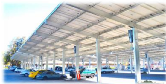
(شكل 6): يوضح المظلات الشمسية لتوليد الطاقة في الأماكن المخصصة لانتظار السيارات بالحدائق العامة [12].
