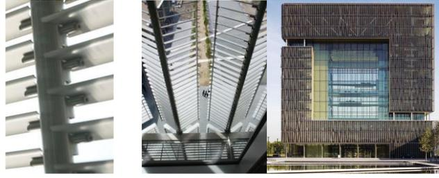
شكل 9 نظام التظليل المستخدم في مبنى شركة (كروب) والذي يتكون من وحدات فولاذية تشبه الزعانف ويتم إدارتها آلياً من خلال وحدة التحكم المركزي بالمبنى.
